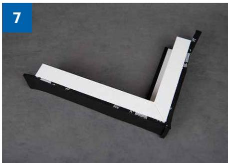
7 > Fensterrahmen vorbereitet zur Montage. Im Eckbereich die Bänder mit Längenzugabe überstehen lassen. Beim Ansetzen von Bändern ebenfalls eine Längenzugabe geben (Welle ausbilden).
