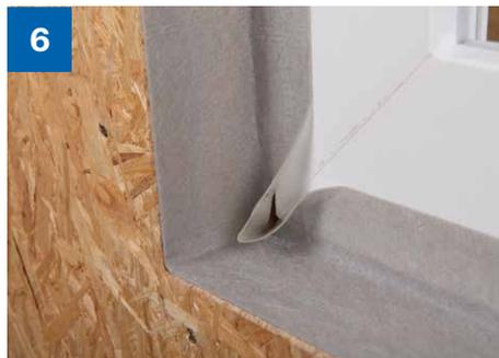
6 > **Tipp:** Montage von Ampacoll® Fenax nach Fenstereinbau umlaufend (ohne Einschnitt und in einem Durchgang). Das Eck kann ohne zu schneiden mittels Quetschfalte ausgeführt werden.
