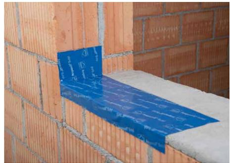
> Prinzipskizze bei Massivbau (links) und Ausführungsbeispiel mit Ampacoll® Sillskin (rechts). Seitlicher Hochzug: DE  $\geq 10$  cm; AT  $\geq 6$  cm. Falls Ampacoll® Sillskin in den Putzbereich der Fassade hineinreicht, seitlichen Hochzug evtl. ausschneiden.
