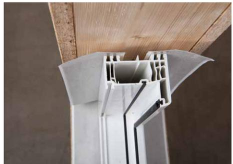
**Beispiel:** Links die zwei vorgefertigten Fenax-Schürzen. Rechts ein Beispiel für den mittigen Einbau in Holzrahmenwand. Die Fuge hohlraumfrei ausdämmen. Die Klebebänder Ampacoll® Fenax spannungsfrei bzw. mit Entlastungsschlaufe anbringen.
