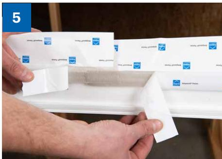
5 > Bei Stößen der Dichtfolien darauf achten, dass die Enden ausreichend überlappen und luft- bzw. wind- und schlagregendicht miteinander verklebt werden.
