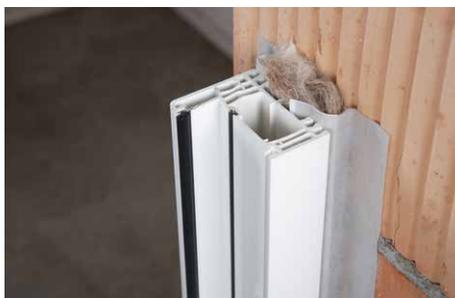
> Ampacoll® Fenax DS für wechselseitige Verklebung an Innen- und Aussenseite des Fensterrahmens kleben und gut anreiben. Ausbildung der Eckschlaufen: ca. 1,5 × Fugenbreite. Fuge hohlraumfrei ausdämmen. Entlastungsschlaufen ausbilden.
