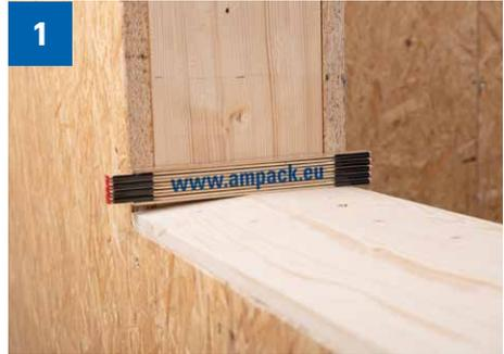
> Ausbildung von  $\geq 5^\circ$  Gefälle im Wandbildner oder durch Einbau von z. B. Holz- oder Dämmkeil.
