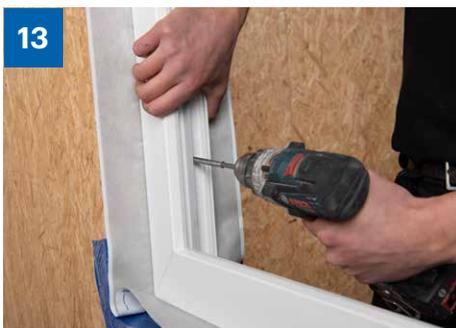
13 > Ausgangssituation: Eingebauter Fensterrahmen mit vorgefertigter Klebeband-schürze. Nach den örtlichen Gegebenheiten bzw. den Angaben des Planers entscheiden, ob mit der Verklebung auf der Innen- oder Aussenseite begonnen wird (Witterung und Baufortschritt berücksichtigen).
