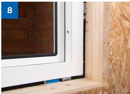
8 > Beim Einsatz von Tragklötzen sind die Multifunktionsbänder auszuschneiden. Der Ausschnitt muss enger sein als die Breite des Tragklotzes (Luftdichtheit).
