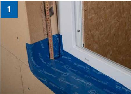
> Nach der Fenstermontage wird die Unterfensterbank mit Ampacoll® Sillskin aussen an den Fensterrahmen geklebt.
