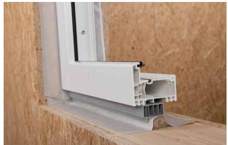
> Ampacoll® Fenax DS für wechselseitige Verklebung an Innen- und Aussenseite des Fensterrahmens kleben und gut anreiben. Ausbildung der Eckschlaufen: ca. 1,5 × Fugenbreite. Fuge hohlraumfrei ausdämmen. Links: ohne Fensteranschlussprofil (FBA). Rechts: mit FBA.
