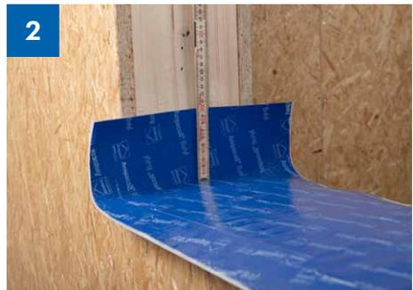
> Ampacoll® Sillskin mit Überlänge für den seitlichen Hochzug zuschneiden und aufkleben. Seitlicher Hochzug: DE  $\geq 10$ cm; AT  $\geq 6$ cm.
