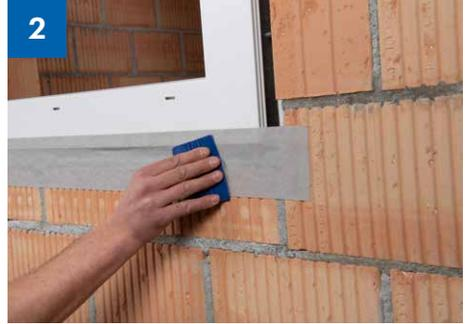
> Klebebänder mit der Anpresshilfe Ampacoll® Pressly oder der Anpressrolle gut anreiben.
