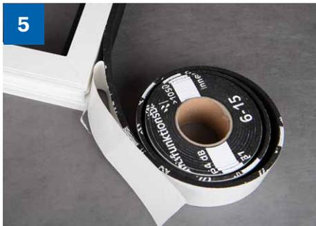
5 > Ampacoll Komprimax bündig mit der Rahmeninnenseite montieren. Ohne Zug/Spannung verlegen.
