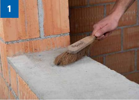
> Untergründe müssen trocken, frostfrei, tragfähig, staub-, trennmittel- und fettfrei sein. Untergründe gut reinigen und auf Tragfähigkeit prüfen.
