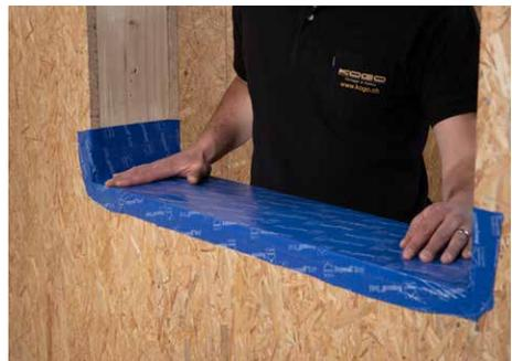
> Durch die hohe Dehnfähigkeit lässt sich Ampacoll® Sillskin auch an den Ecken mühelos verlegen. Es entsteht eine durchgehende Abdeckung aus einem Stück.
