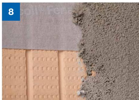
8 > Die luftdichte Ebene wird mit dem anschliessenden Verputzen des Bandes hergestellt.
