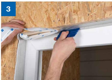
> L'outil de placage Ampacoll® Pressly est également très utile pour former les boucles de détente.
