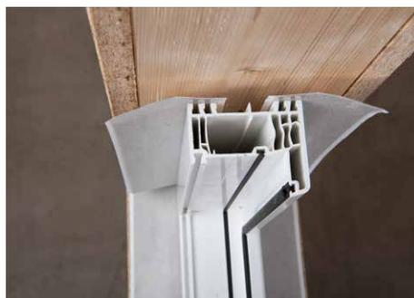
**Exemple :** à gauche, les deux tabliers Fenax préfabriqués. À droite, exemple d'intégration centrale dans une paroi à montants en bois. Bien combler les joints avec l'isolant. Appliquer les rubans adhésifs Ampacoll® Fenax sans tension et en formant des boucles de détente.
