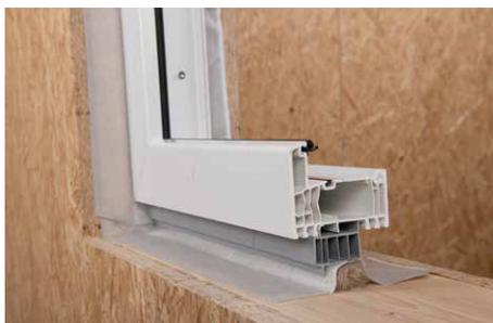
> Coller et appliquer fermement Ampacoll® Fenax DS pour collage mixte du côté intérieur et extérieur du cadre de fenêtre. Boucles de détente : env. 1,5× la largeur du joint. Bien combler les joints avec l'isolant. À gauche : sans profilé de raccord de fenêtre (FBA). À droite : avec FBA. **Remarque :** Tenir compte de la configuration de l'appui de fenêtre, voir pages 17-19 : deuxième couche d'étanchéité / dessous d'appui de fenêtre.
