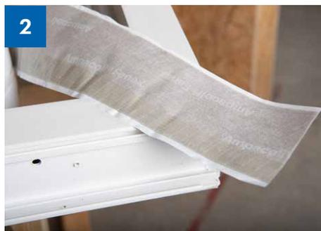
2 > Ruban de raccord de fenêtre utilisé : Ampacoll® Fenax 30/45 DS (adhésif double-face, surface adhésive de 20 mm à l'avant).
