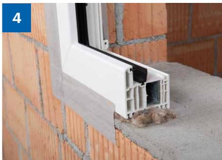
> Comblir les joints avec le matériau isolant prescrit par le planificateur.
