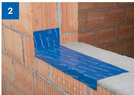
> Si Ampacoll® Sillskin déborde sur la zone à enduire de la façade, découper latéralement les remontées. Le châssis de fenêtre peut désormais être positionné dans l'ouverture et fixé.
