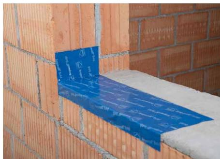
> Schéma de principe pour la construction massive (à gauche) et exemple de mise en œuvre d'Ampacoll® Sillskin (à droite). Remontée latérale : DE  $\geq$  10 cm ; AT  $\geq$  6 cm. Si Ampacoll® Sillskin déborde sur la zone à enduire de la façade, découper éventuellement la remontée latérale.
