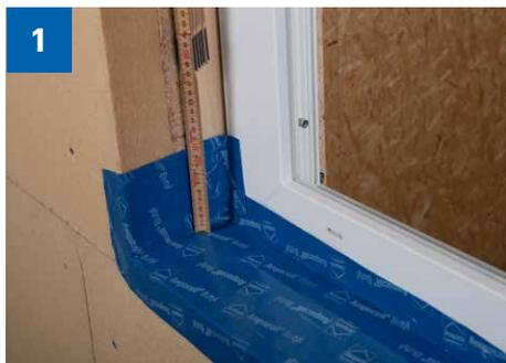
> Après la pose de la fenêtre, le dessous de l'appui de fenêtre est raccordé au châssis de la fenêtre à l'aide d'Ampacoll® Sillskin.
