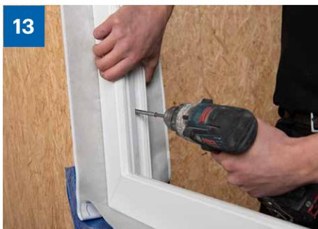
> Situation de départ : Châssis de fenêtre en place avec tablier de ruban adhésif préfabriqué. En fonction des spécificités locales ou des indications du planificateur, décider si le collage doit commencer côté intérieur ou extérieur. (Tenir compte des intempéries et de l'avancement du chantier).
