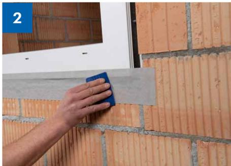
> Appliquer soigneusement les rubans adhésifs à l'aide de l'outil de placage Ampacoll® Pressly ou d'une roulette.
