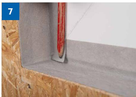
> Bien souder le pli puis le replier vers le bas (écoulement de l'eau).
