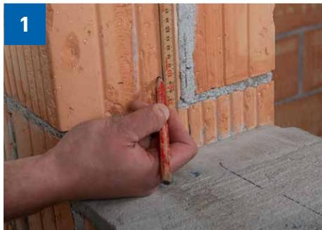
> Repérer la position dans l'embrasure. Puis, découper Ampacoll® Sillskin en prévoyant une surlongueur pour les remontées latérales et le coller en veillant à bien l'appliquer sur toute la surface. Remontée latérale :  $DE \geq 10 \text{ cm}$  ;  $AT \geq 6 \text{ cm}$ . **Remarque** : dans cet exemple, le dessous d'appui de fenêtre a été réalisé sans pente. La pente peut être formée directement par le matériau de la paroi ou en mettant en place une cale appropriée.
