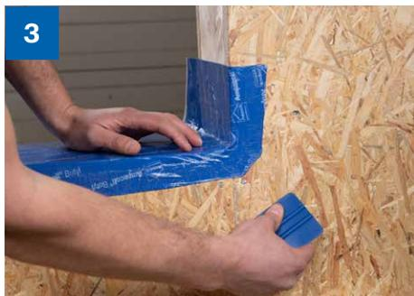
> Grâce à son dilatabilité, Ampacoll® Sillskin se pose aussi aisément dans les angles, ce qui permet de réaliser une couverture continue d'une seule pièce.
