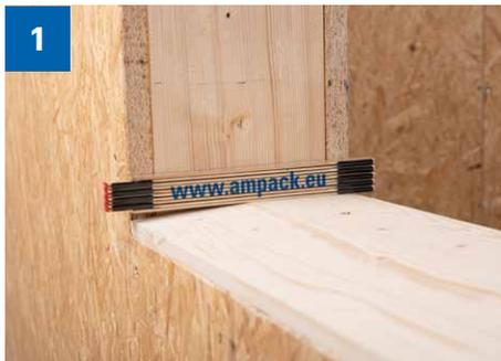
> Création d'une pente  $\geq 5^\circ$  dans la paroi ou intégration d'une cale de bois ou d'isolation.
