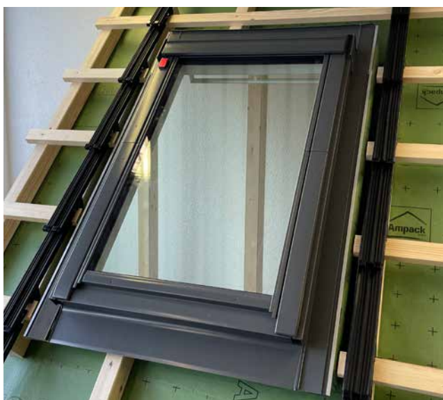
Fertig montierter Eindeckrahmen ODL.
