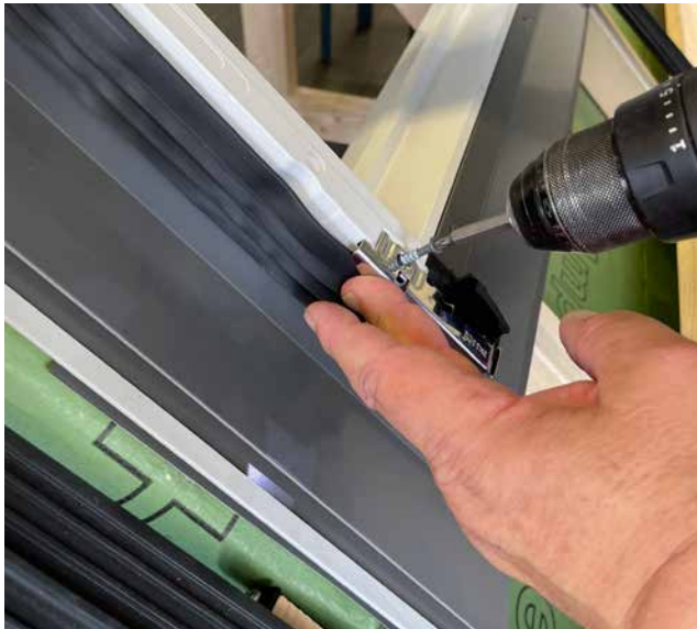
Drainagen 2a und 3a am Eindeckrahmen anbringen.
