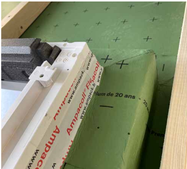
Abkleben der Unterdachbahn am Dachfenster.
