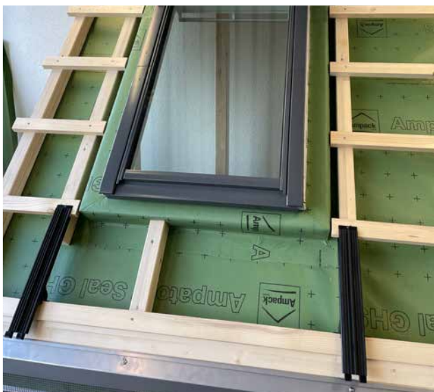
Megasol MATCH Slate Haken anbringen gemäss Planungsinformation oder individuelle Einteilung.
