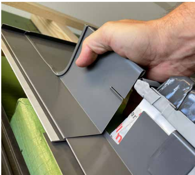
Kopfstück Eindeckrahmen in den seitlichen Falz einschieben.
