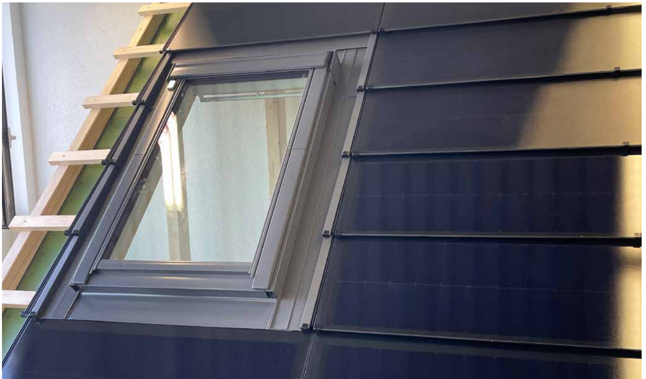
Dachfenster der Grösse MK06 78x118cm mit original VELUX ODL Eindeckrahmen, MATCH slate Module Mxx-HC24 (Optik totallyblack Crystal / Fjord)
