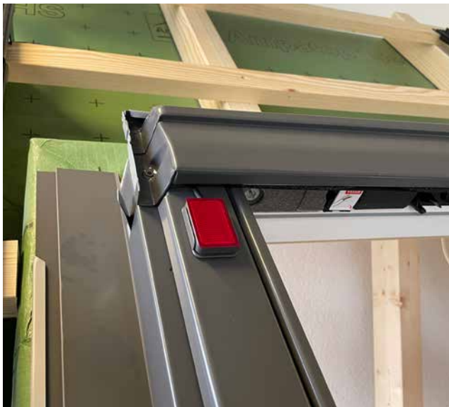
Montage des Markisenkastens.
