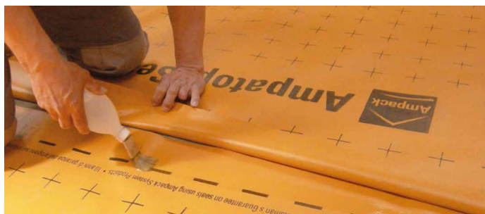
3 Saldatura con Ampacoll® LiquiSeal
