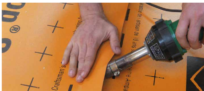
4 Saldatura con aria calda
