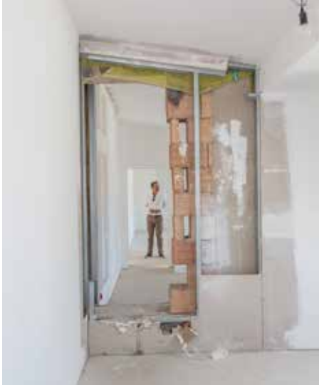
IM BAU. Die Wohnungstrennwände werden noch zwischen den Wohnungen geschlossen (im Bild: Martin Kienl).
