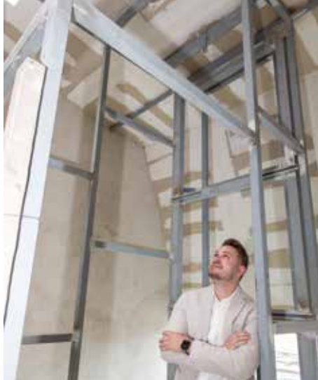
AUSBAU. Das gesamte Stiegenhaus samt Dachkuppeln wurde mit Trockenbau ausgebaut (im Bild: Christian Fellner).
